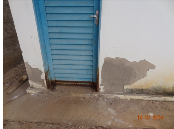
Foto 2 – Casa do clorador
