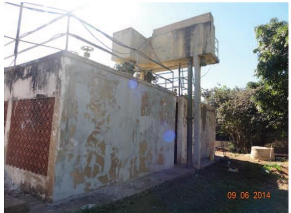
Foto 10 – Presença de fissuras e infiltrações
