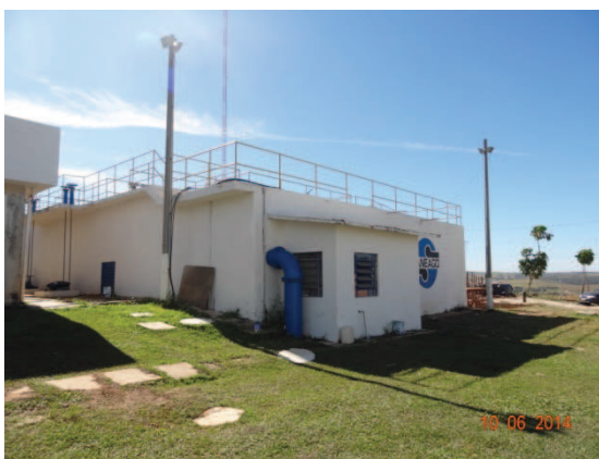
Foto 5 – Pintura e revestimento recuperado
