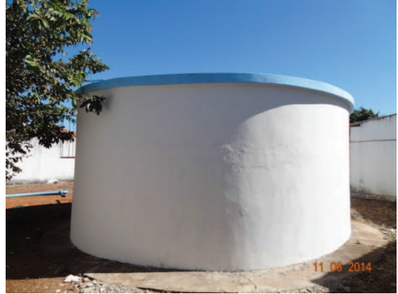
Foto 2 – Pintura restaurados - Res. Céu Azul
