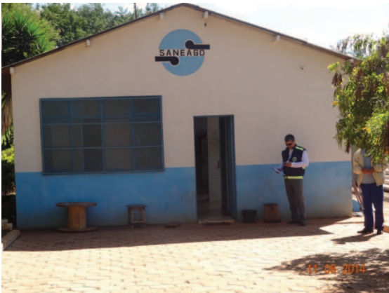
Foto 3 – Pintura e revestimento recuperado
