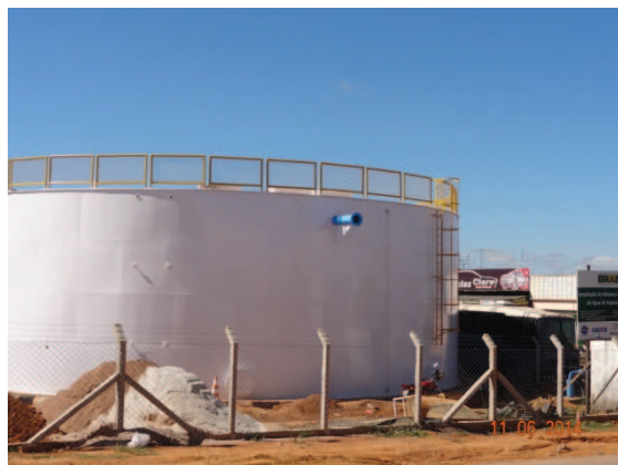
Foto 13 – Reservatório em construção
