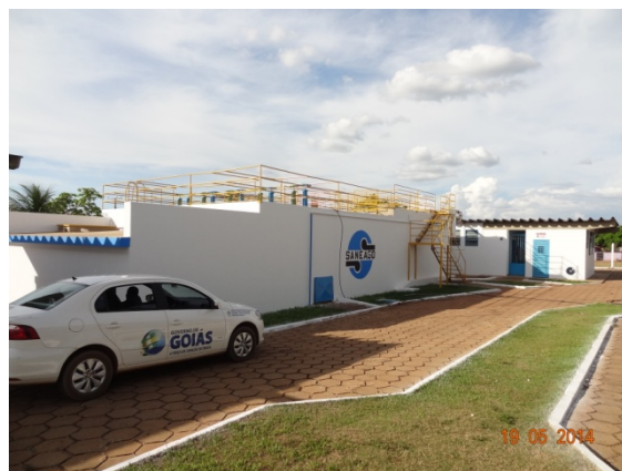
Foto 2 – Pintura recuperada – ETA.
