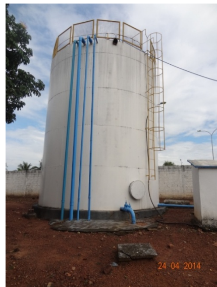
Foto 02 – Reservatório Apoiado com guarda-corpo instalado
