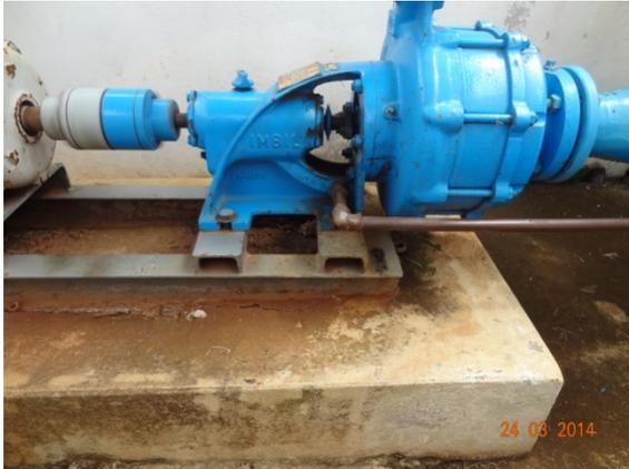
**Foto 1** - Ausência de vazamento.
