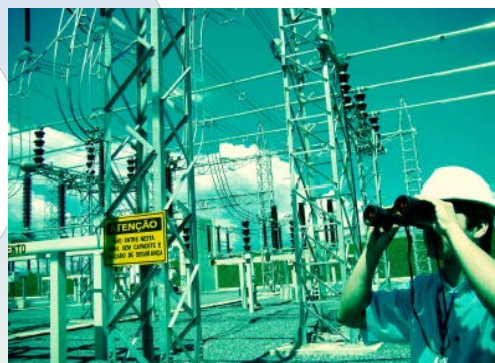
Energia Elétrica - Convênio com a ANEEL
