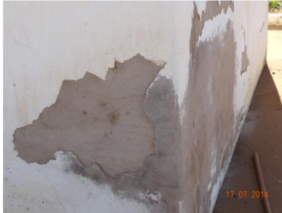
Foto 1 – Casa do clorador
