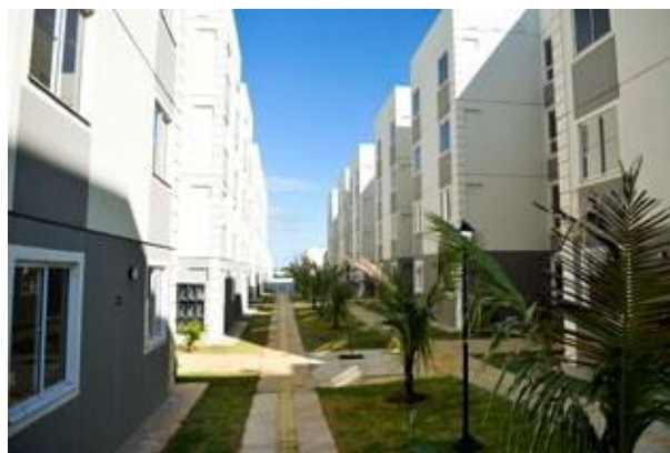
Com a finalização da terceira etapa do Porto Dourado, em Goiânia, já são 1.408 apartamentos entregues somente neste residencial na gestão Ronaldo Caiado
