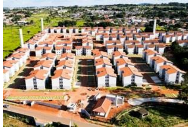
Obra do governo federal paralisada em 2013, a construção de 900 apartamentos na Chácara São Pedro em Aparecida de Goiânia foi retomada graças ao aporte de recursos do Governo de Goiás, que entrou com R$ 4,5 milhões do Crédito Parceria
