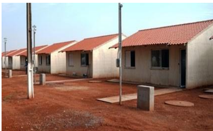
As moradias de Ivólândia já estão com 95% de execução
