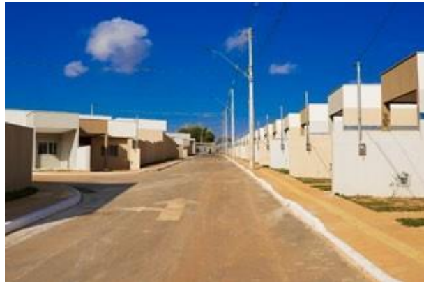
Residencial Village dos Buritis recebeu investimento estadual de R$ 1,3 milhão para construção de 113 casas em Senador Canedo
