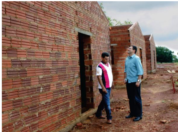
Figuras 01: Presidente da AGEHAB em visita às obras do PMCMV, de Itaguaru.
