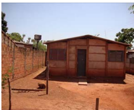
Figura 04: Casa de Placas de cimento
