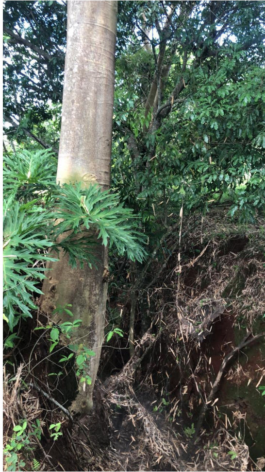
Foto 10 – Área com médio processo erosivo, nas proximidades da voçoroca. (FONTE PROPRIA)
