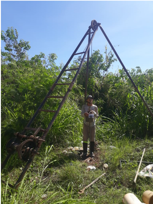
Figura 3. Foto da execução no local.
