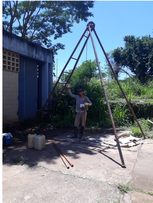
Figura 4. Foto da execução no local
