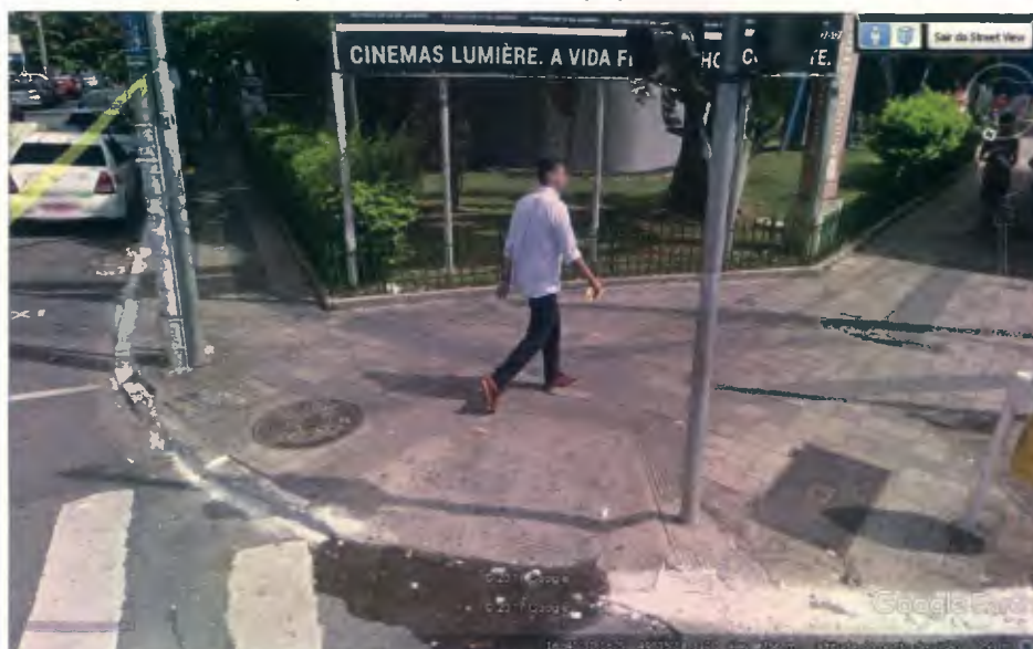
Imagem 12 – Passeio com rampa para cadeirantes
