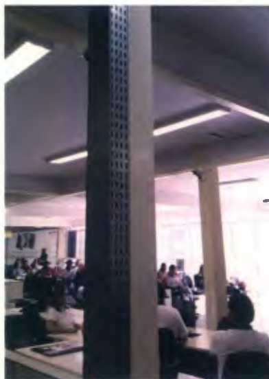
Imagem 31 – Eletrodutos com descidas externas aos pilares
