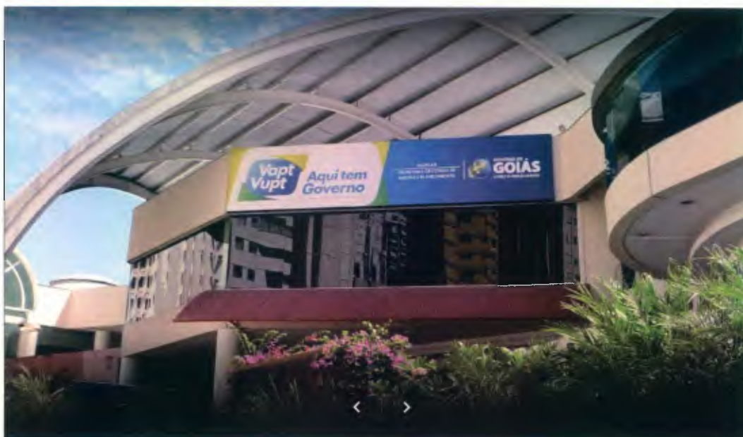
Imagem 03 – Vista Unidade VAPT VUPT
