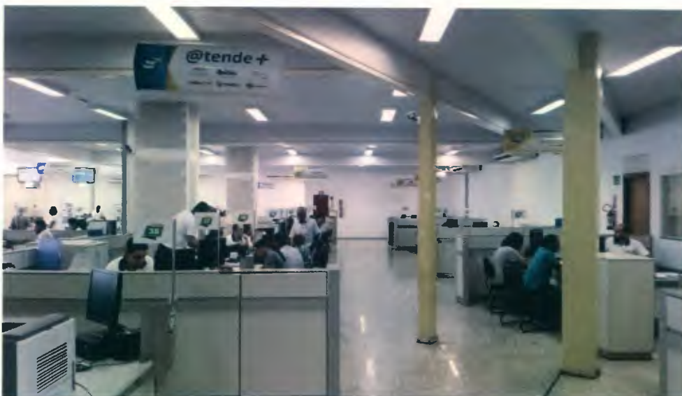
Imagem 27 – Pilares nas áreas internas da Unidade
