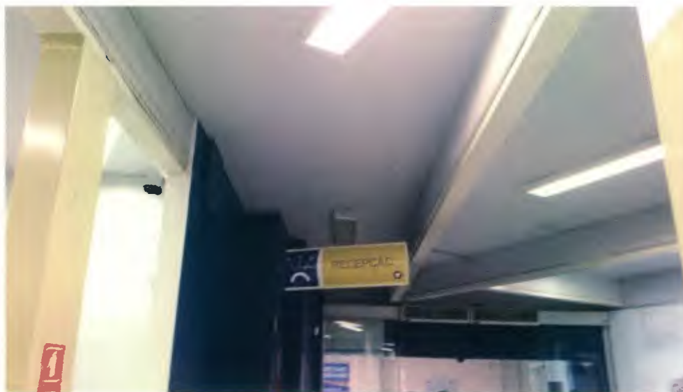
Imagem 28 – Pilares metálicos para reforço de estrutura
