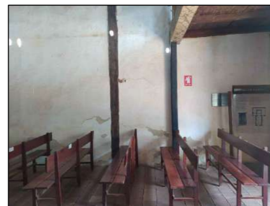
Foto 4 - Vista parede lateral com deslocamento de pintura, trincas e sujidade.
