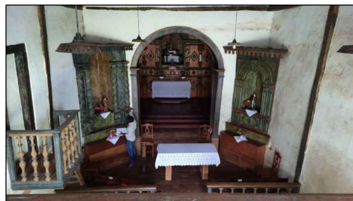
Foto 1 - Vista do altar desgastados, parede com sujidade.
