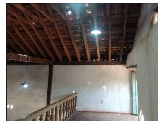
Foto 5 - Vista parede lateral com deslocamento de pintura, trincas e sujidade.
