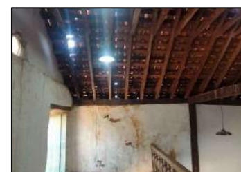
Foto 3 - Telhas quebradas.
