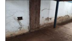
IMAGEM - Esquadrias em madeira danificadas e com deslocamento de pintura
