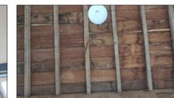
IMAGEM - Deslocamento da pintura nas paredes e esteio danificado
