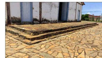
IMAGENS FACHADA LATERAL DIREITA - Sujidades, deslocamentos de pintura, fissuras, perdas de partes e manchas escuras nas paredes e no piso
