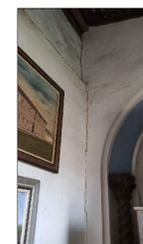
IMAGEM - Fissuras nas paredes
