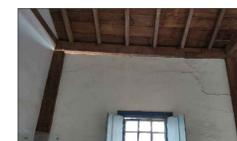
IMAGEM - Fissuras nas paredes
